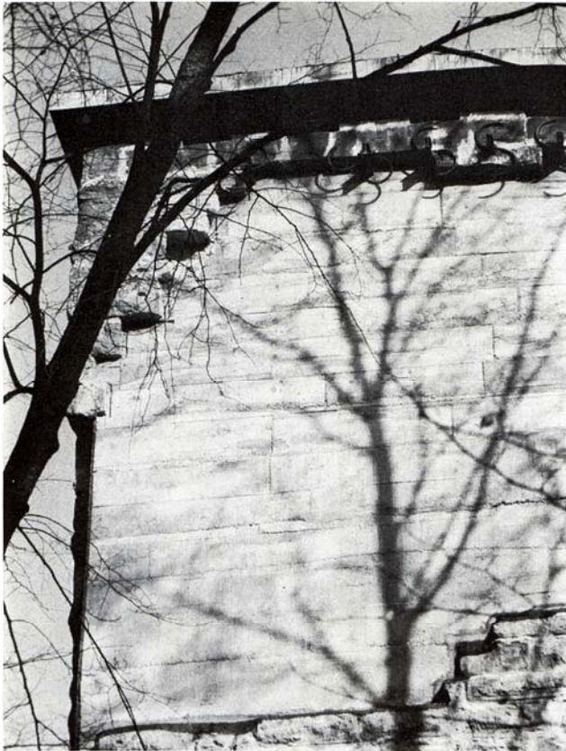
Abb. 5. Röterturm. Ausschnitt der sanierten Mauerfläche in Sichtbeton (Bleiabdeckung der Absätze)
